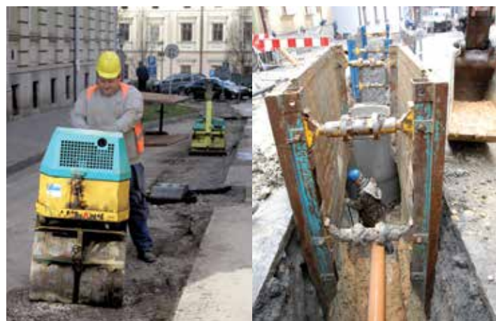
Zdjęcie z lewej: zagęszczanie wykopu na ul. Kochanowskiego. Zdjęcie z prawej: ul. Sejmowa - wykonywanie robót instalacyjnych na dużych głębokościach z zastosowaniem „szalunku”.
