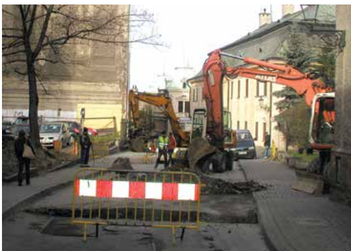
Roboty budowlane w ul. Kochanowskiego.
